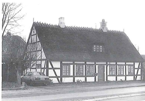
Spindeskolen fra 1782 i den gamle landsby. Bygningen fungerede kun som spindeskole til 1795. Siden har den været brugt til bolig, en overgang for sognets jordemoder. Der er tale om godsbyggeri, der bl.a. adskiller sig fra bøndernes eget byggeri gennem det langt kraftigere tømmer. (Haslev Museum).
