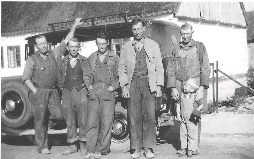
Montør Chr. Hansen fra SEAS fotograferet i 1938 med sit hold på fire ledningsarbejdere. Chr. Hansen står yderst til venstre. Ved siden af ham Karl Larsen, der var begyndt på SEAS i 1934. Han startede med at tjære master, men kom snart med på et ledningshold og endte selv som montør. Han stammede fra Jylland og var begyndt som landvæsenselev på nogle store gårde. Derefter var han chauffør forskellige steder i landet og kom i 1926 til Haslev, hvor han blev tjenerchauffør hos sagfører Ehlers Damgaard. Derefter arbejdede han som chauffør hos en vognmand i byen, indtil han fik arbejde på SEAS. (Foto i privateje).
