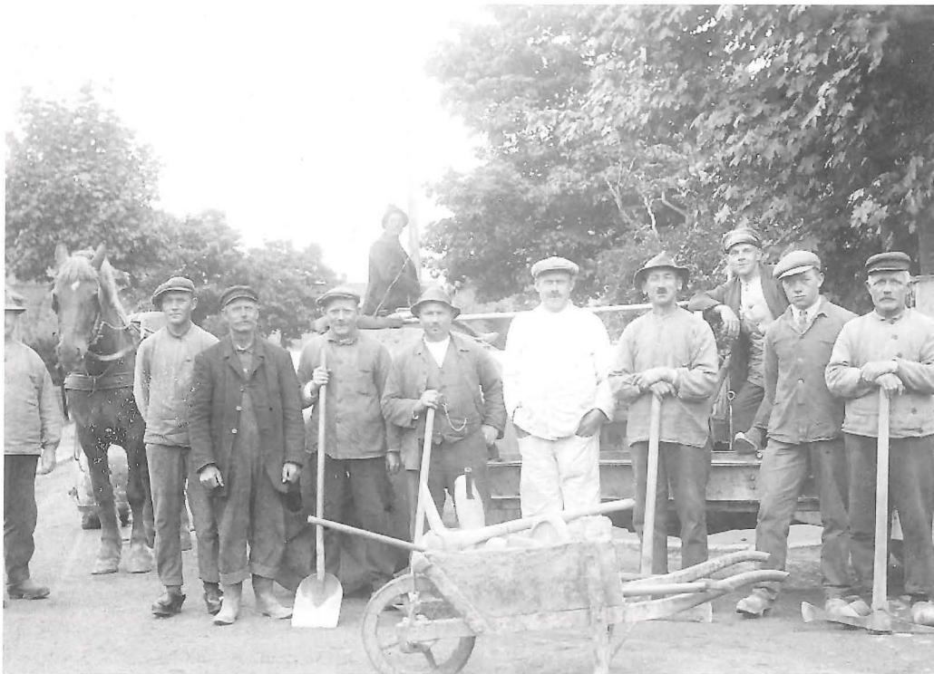
Vejarbejdere, formentlig i 1930'erne. Kommunen anskaffede en motortromle i 1927, men der var stadig brug for en hestetrukken tromle og mange mænd med skovle, hakker og trillebør. (Lokalhistorisk Arkiv).
